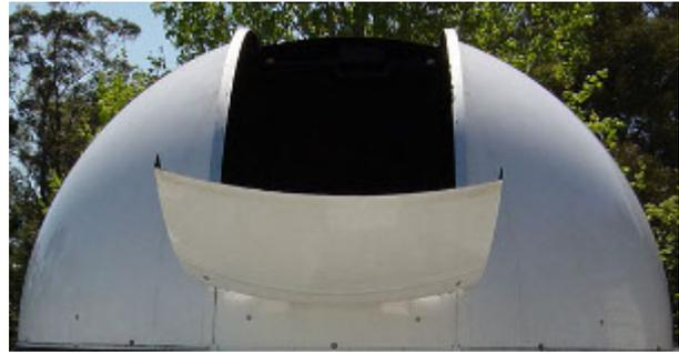
ma soluzioni ancora più semplici possono essere adottate, ad esempio effettuando uno spostamento della cupola secondo avanzamenti temporizzati servendosi di un fotocellula o di un qualsiasi altro sensore solidale al telescopio che faccia progredire la rotazione della cupola di una decina di gradi ogni volta che la cella ricevente perde il segnale.
